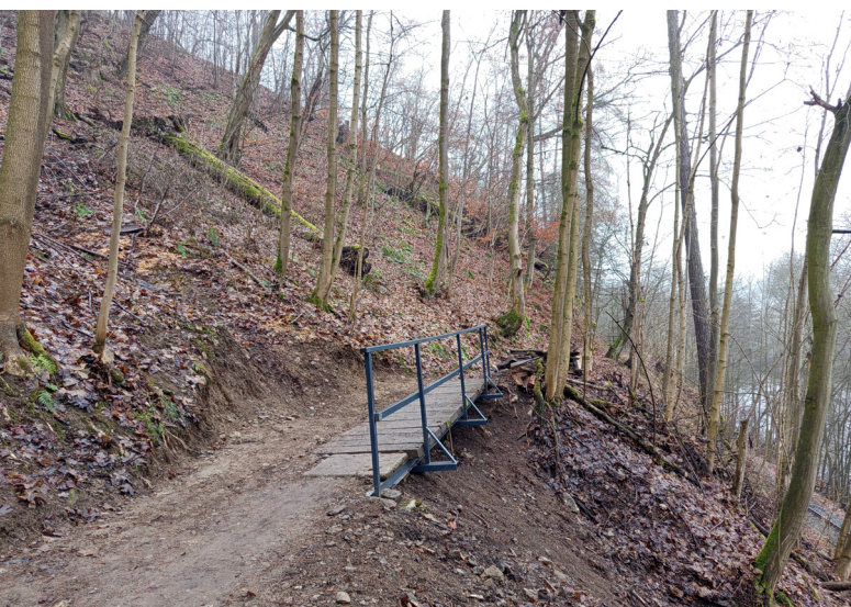
Opravená lávka na hvězdonicé stezce
