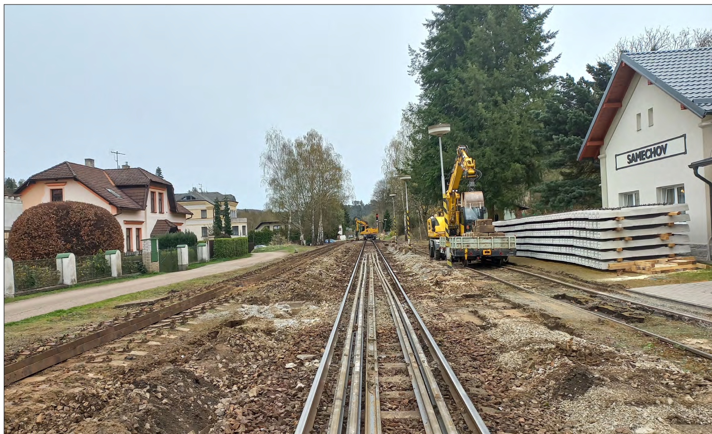
Rekonstrukce kolejiště na nádraží Samechov
