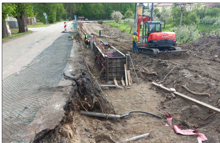
Stavba opěrné zídky pod silnicí na Komorním Hrádku
