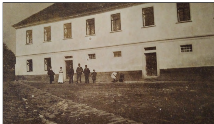
Sokolovna před přestavbou
