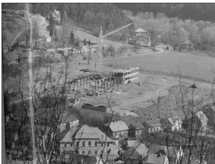
Stavba nové základní školy
