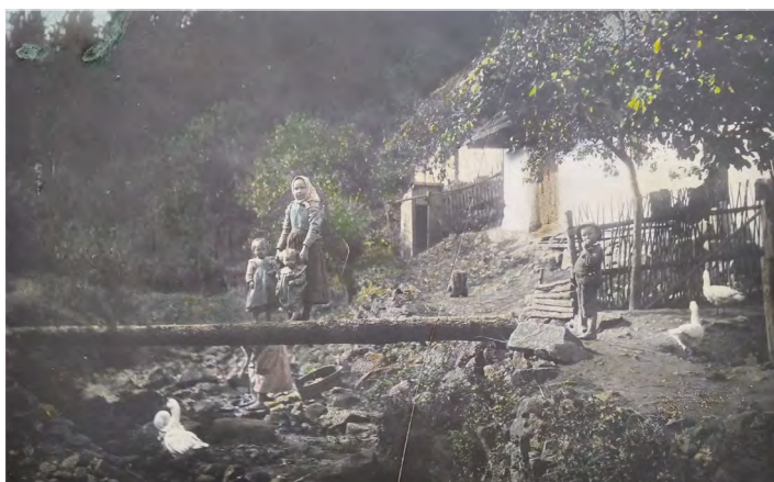
Potok na Malé straně s lávkou
