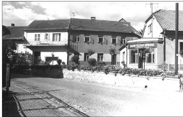
Opravna televizi a rádií, vlevo mlékárna
