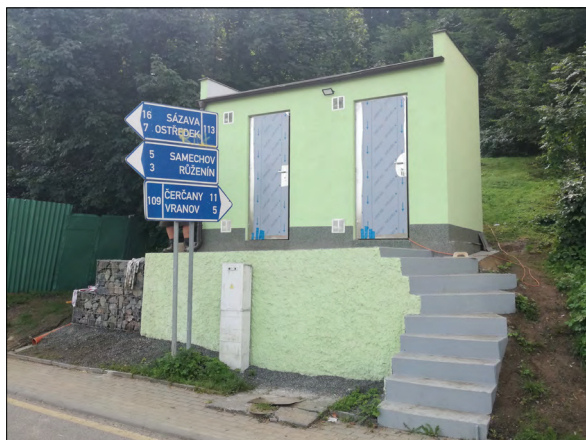
Nová čerpací stanice u mostu
